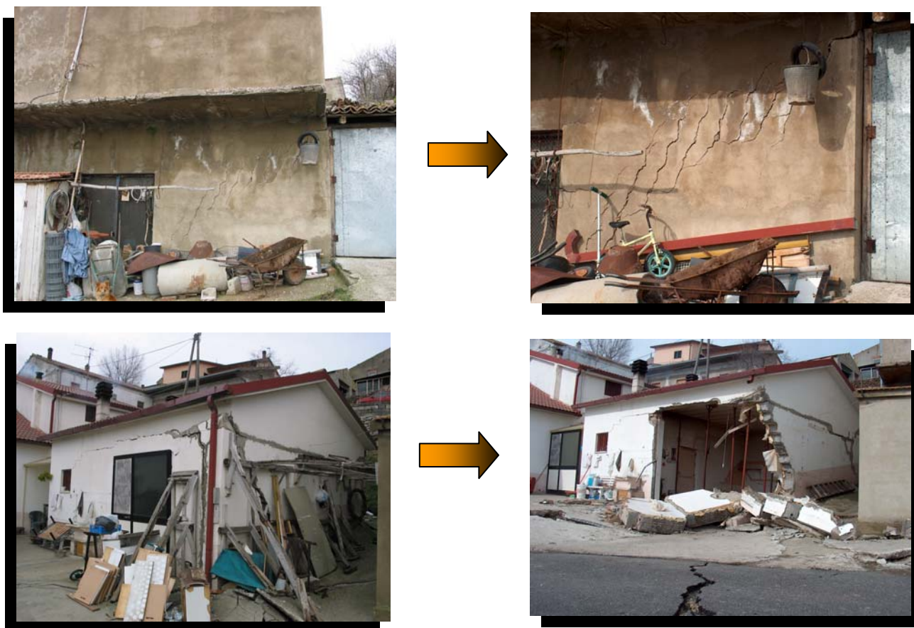
Figura 2. Evidenze fotografiche del peggioramento delle condizioni statiche degli edifici dal 25 al 27 febbraio.
