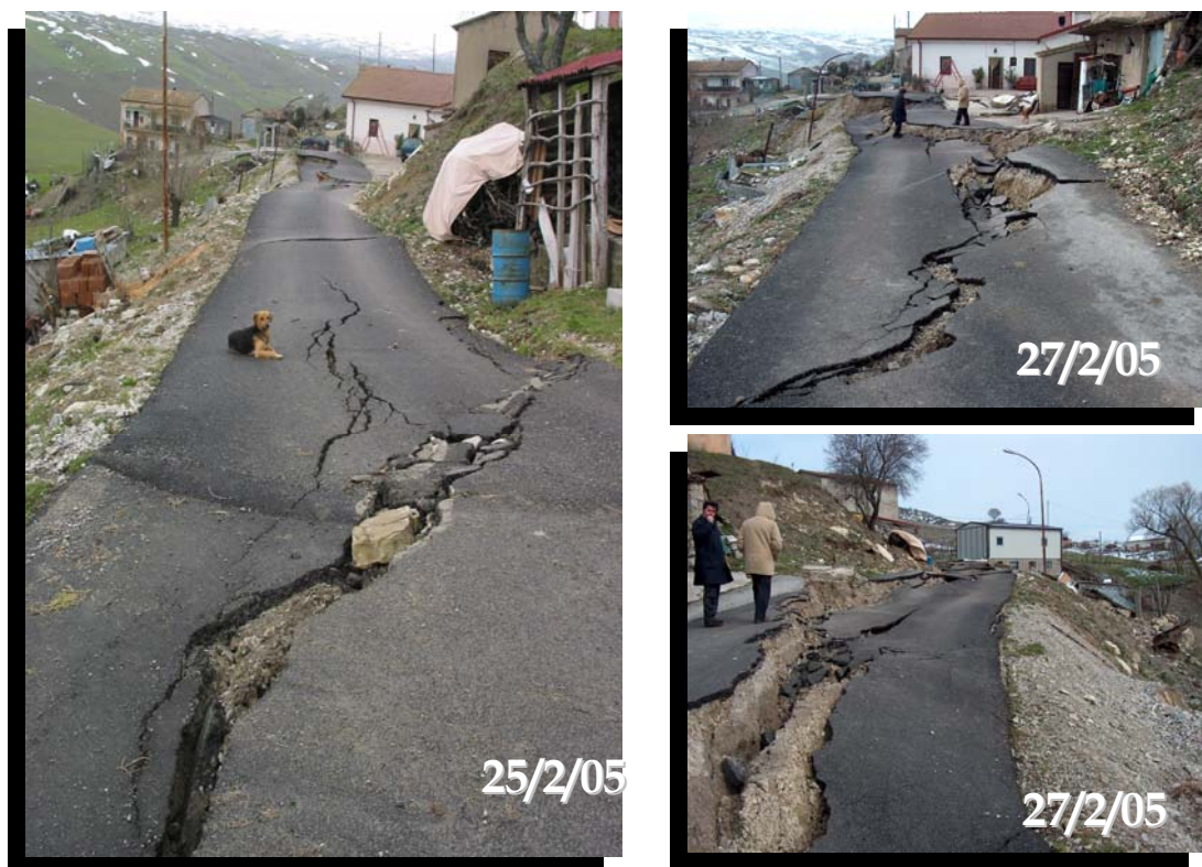
Figura 3. Incremento dei danni alla rete stradale per l'accelerazione del fenomeno franoso.
