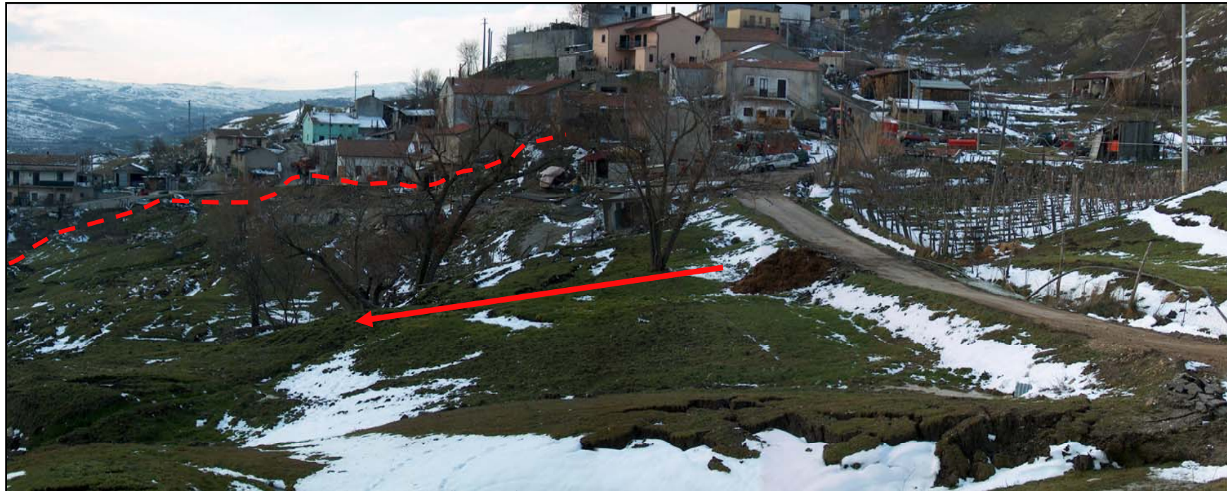
Figura 9. Parte centrale della frana di Bosco Piccolo con evidenti rigonfiamenti e relative crepe nel terreno con la formazione di gradini in contropendenza per effetto della rototraslazione del corpo di frana.
