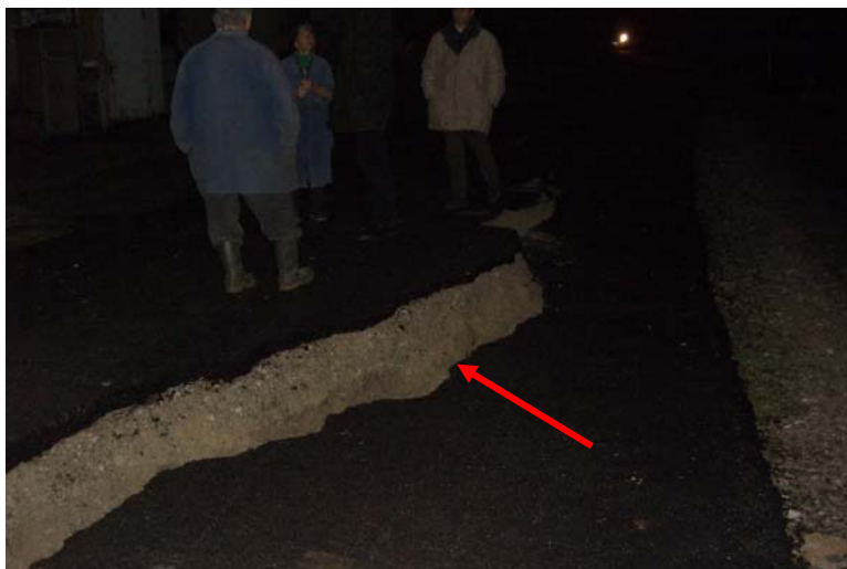
Figura 1. Evidenza di una dislocazione del manto stradale in località Bosco Piccolo verificatasi il giorno 24 febbraio 2005.
